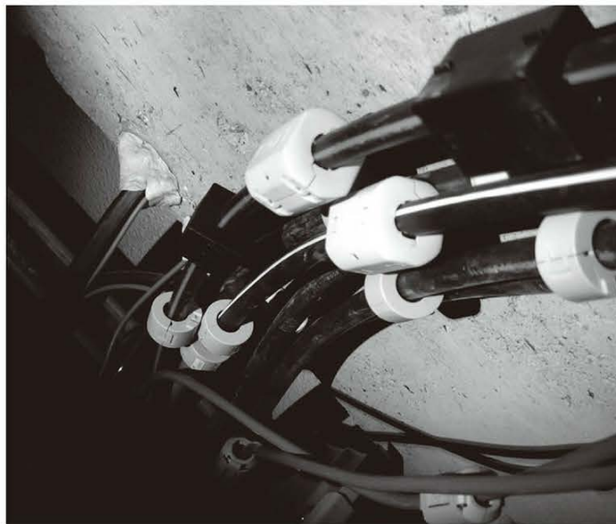
↑写真8/壁内にある電源線やCATVのケーブル類50本ほどに分割フェライトコアを取り付けた。
